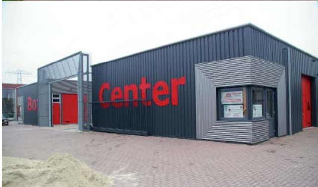
Voorbeeld van een representatieve gevel, een eenvoudige hoofdvorm, een terughoudend kleurgebruik en ondergeschikte kleuraccenten die het gevelbeeld versterken.
