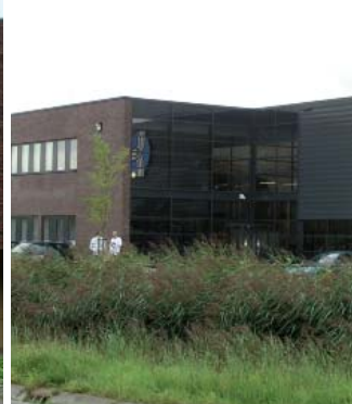
Voorbeeld representatieve architectuur en kleur- en materiaalgebruik (roodbruine baksteen in combinatie met hout of antraciete sandwichpanelen).
