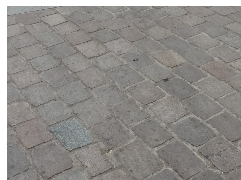
Natuursteen Bovenzijde gezaagd Kleur: grijs Afmetingen: 14x20 cm Voeg: vast en waterdoorlatend
