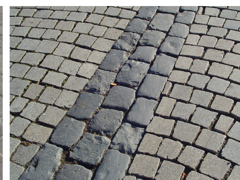
Markering parkeerplaatsen t.p.v. natuursteen plint rond kerk Bovenzijde gezaagd Kleur: zwart Afmetingen: 14x20 cm Voeg: vast en waterdoorlatend
