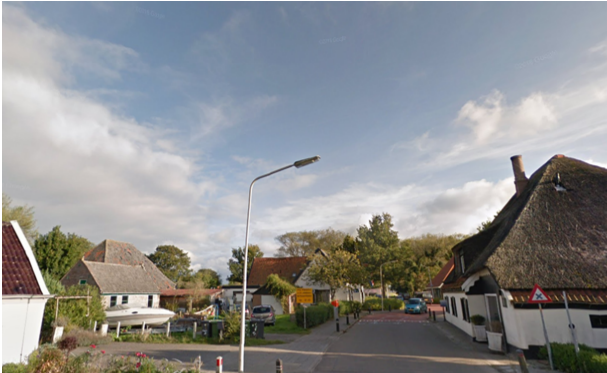
Bebouwing aan de Weereweg; de stolpboerderij aan de Mientweg 46 is nog net te zien achter het rieten dak (bron: street view Google Maps)
